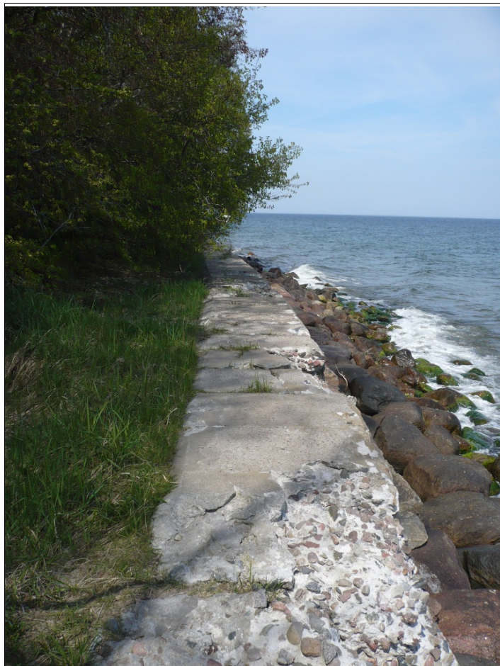
Spękany mur oporowy poniżej osuwiska
