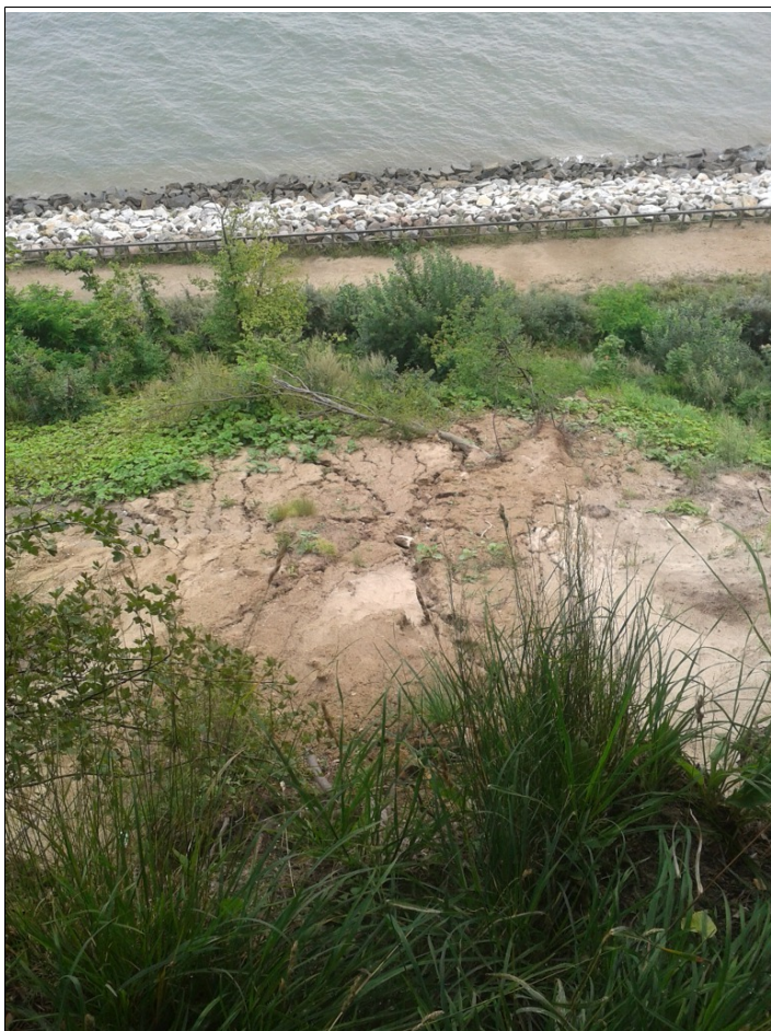
Aktywna część osuwiska, zabezpieczona ochronną opaską brzegową
