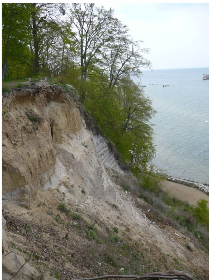
Aktywna część osuwiska, zabezpieczona ochronną opaską brzegową
