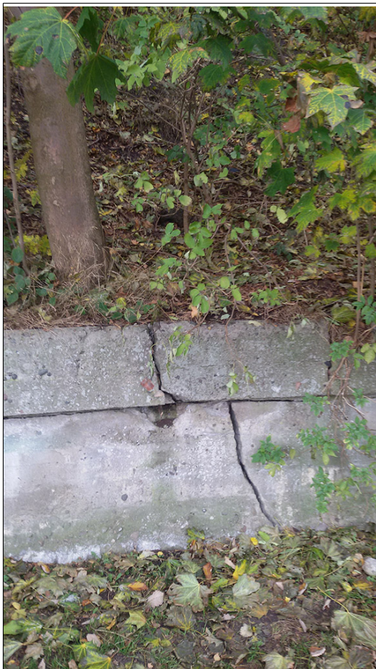
Spękany murek oporowy w obrębie osuwiska
