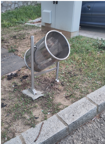
Rys. 26. Uliczne kosze na śmieci na obszarach graniczących z parkiem Collserola. Na dwóch pierwszych zdjęciach widoczne uszkodzenie powodujące możliwość obrotu kosza na śmieci (fot. R. Skrzypczyński).
