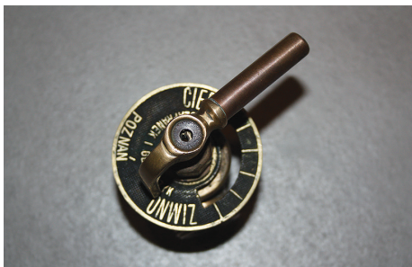
Zawór grzejnikowy z budynku przy ul. Waszyngтона 38 po renowacji
