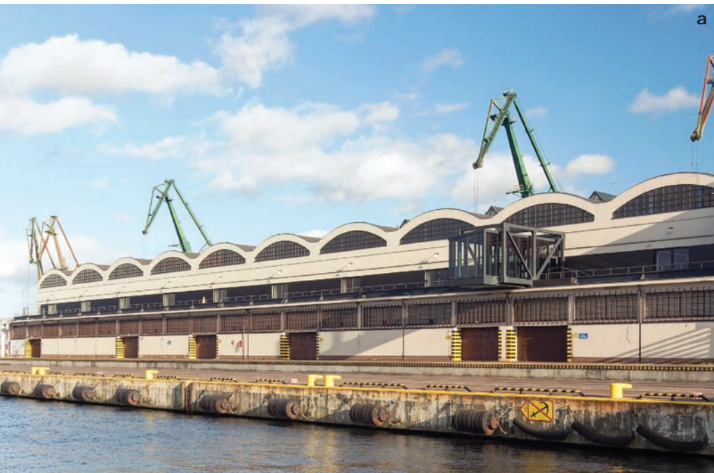
15. Dawny Magazyn Tranzytowy przy Dworcu Morskim (dziś część Muzeum Emigracji), projekt katowickiego oddziału firmy „Dyckerhoff & Widmann”, ukończenie budowy w grudniu 1933 r.: a. fragment elewacji północnej z widocznym ciągiem powłok kolebkowych systemu Zeiss-Dywidag (fot. B. Ponikiewski); b. powłoka kolebkowa wnętrza ze świetlikiem (fot. B. Ponikiewski)
