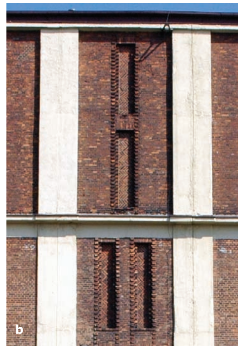
10. Chłodnia Portowa przy ul. Polskiej 20 w Gdyni, projekt firma „Ateliers B. Lebrun, Société Anonyme, Nimy”, budowa w dwóch etapach w latach 1928-1930 i 1933-1934: a. struktura ściany z wyeksponowaną ramą żelbetową i wypełnieniem cegłą (fot. M. J. Sołtysik); b. detal ściany frontowej (fot. M. J. Sołtysik, 2009)
