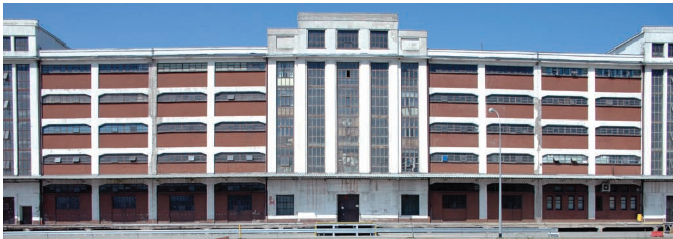
13. Magazyn Długoterminowy Nr 5 przy ul. Polskiej 17 w Gdyni, projekt Konstanty Jaskulski z „Biura Inżynierskiego K. Jaskulski i K. Brygiewicz”, budowa w dwóch etapach w 1931 r. i 1934 r. (fot. M. J. Sołtysik, 2009)
