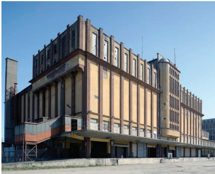
21. Chłodnia Rybna (obecnie Chłodnia Nr 1) przy nabrzeżu Angielskim w Gdyni zbudowana w latach 1948-1952 (fot. B. Ponikiewski)
