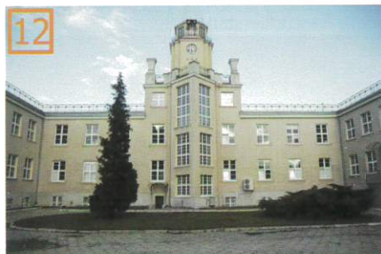
Gmach Urzędu Morskiego, ul. Chrzanowskiego 10 Budynek wzniesiony w 1928 r. wg projektu poznańskiego architekta A. Ballenstedta, obecnie zamyka oś widokową ul. Wendy. Bryła budynku o reprezentacyjnej formie zwieńczona jest wieżą i nawiązuje do pałaców klasycystycznych, ale dekoracje architektoniczne elewacji reprezentują już styl art deco.
