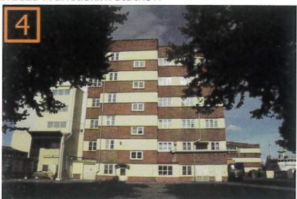
Zespół budynków łuszczarni ryżu , ul. Celna 2
