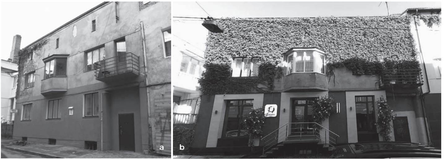
4. Dom czynszowy na ul. Kryłowa, 6 w Łucku, 1936 r., arch. Sergij Tymoszenko: a) zachowana elewacja zgodna z projektem (źródło: zdjęcie autorki, 2016); b) zmiana fasady (źródło: zdjęcie autorki, 2023)
