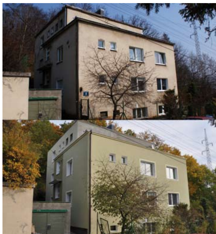
6. Dom przy ul. Kwidzyńskiej 2 w Gdyni. Stan przed i po termomodernizacji przeprowadzonej w 2010 r. (fot. autor)
