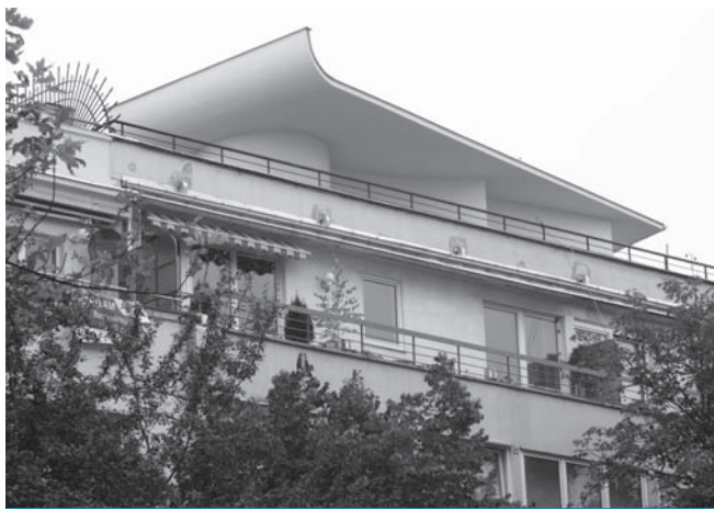
6. Dom przy Alei Przyjaciół w Warszawie, daszek nad ostatnią kondygnacją (fot. autorki, 2014)
