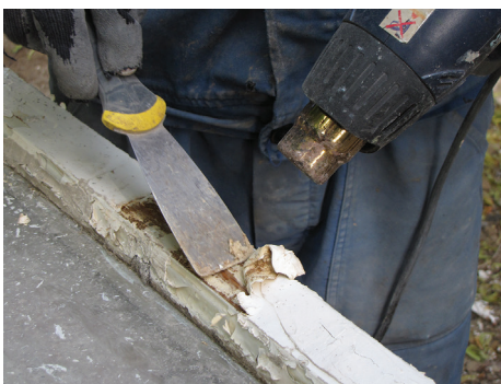
4, 5, 6. Dekoracyjny detal okien d. Zajazdu Adlera przy ul. Orłowskiej 8 w trakcie prac konserwatorskich. Prace konserwatorskie polegały m.in. na usunięciu powłok malarskich poprzez podgrzewanie i zdejmowanie szpachelką grubych warstw farby, następnie uzupełniane były ubytki w drewnie, elementy były szlifowane, malowane i ponownie szklone. Część zniszczonych elementów trzeba było zrekonstruować, ale okna pochodzą z XIX w. Prace wykonano w ramach kompleksowej rewaloryzacji budynku trwającej w latach 2011-2013.
