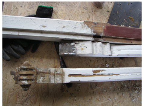
4, 5, 6. Dekoracyjny detal okien d. Zajazdu Adlera przy ul. Orłowskiej 8 w trakcie prac konserwatorskich. Prace konserwatorskie polegały m.in. na usunięciu powłok malarskich poprzez podgrzewanie i zdejmowanie szpachelką grubych warstw farby, następnie uzupełniane były ubytki w drewnie, elementy były szlifowane, malowane i ponownie szklone. Część zniszczonych elementów trzeba było zrekonstruować, ale okna pochodzą z XIX w. Prace wykonano w ramach kompleksowej rewaloryzacji budynku trwającej w latach 2011-2013.
