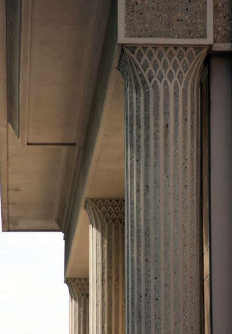
8. Kolumna betonowa kwartału S29 będąca ilustracją pojęcia klasycyzmu strukturalnego zdefiniowanego przez architekta-historyka, Josepha Abrama © Miasto Hawr.
