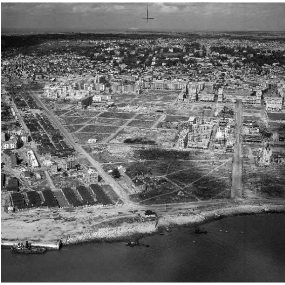
2. Widok centrum miasta w trakcie odbudowy, ok 1959 r. © GPMH.
