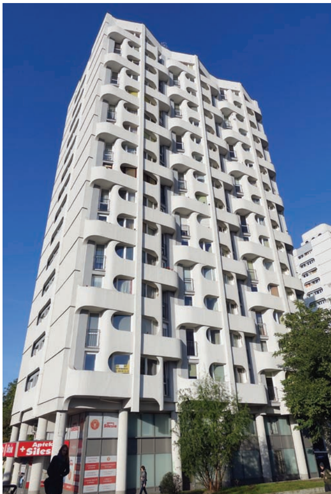
4. Wrocław, zabudowa przy placu Grunwaldzkim nr 4-20, arch. J. Grabowska-Hawrylak, 1967-1973 (fot. B. Ciarkowski, 2019)
