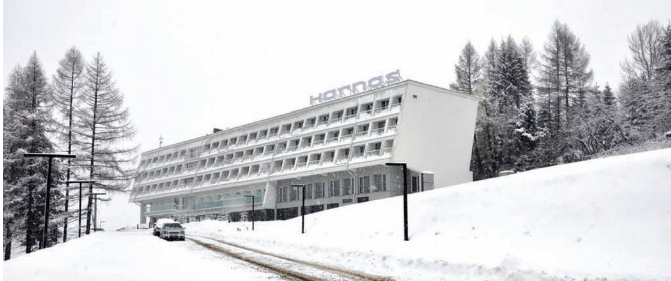
6. Bukowina Tatrzańska, dom wczasowy „Harnaś” po modernizacji, Wierch Buńdowy 11, arch. arch. P. Gawor, L. Filar i J. Pilichowski, 1962-1967 (fot. B. Ciarkowski, 2018)
