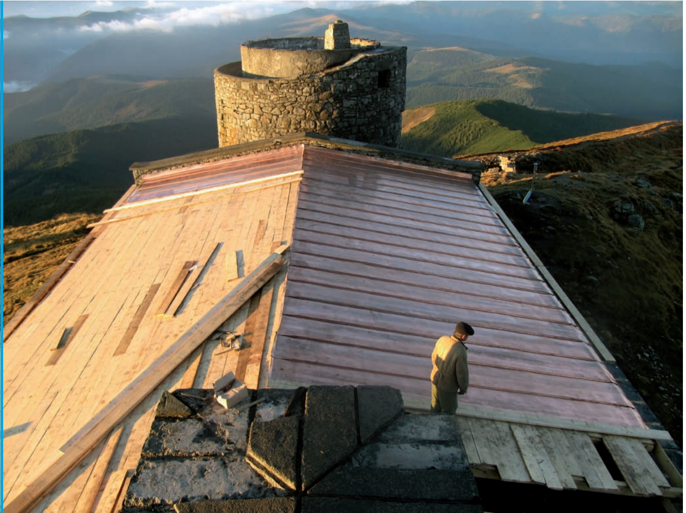
9. Obserwatorium astronomiczno-meteorologiczne im. Marszałka J. Piłsudskiego na górze Pop Iwan w Czarnohorze – budowa i krycie dachu nad głównym korpusem budynku. Stan w 2012 (fot. Wołodymyr Idak)
