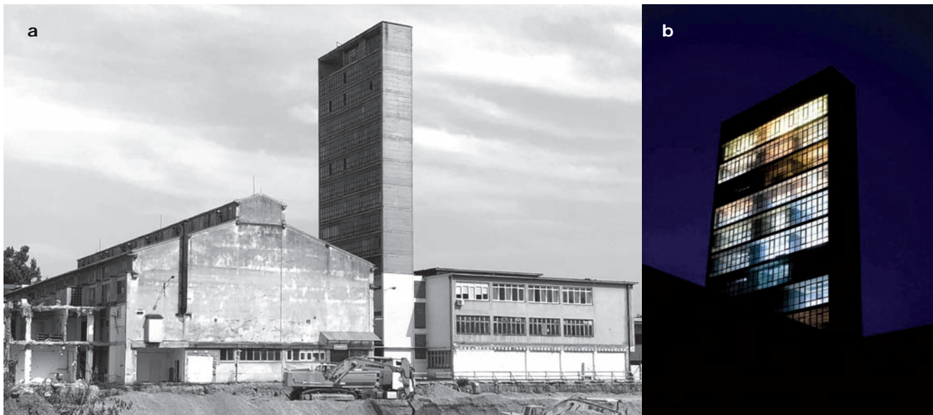
1. Fabryka żarówek „TEŽ” w Zagrzebiu (Chorwacja) przy ul. Frana Folnegovića 10, architekt: Lavoslav Horvat, ukończenie budowy 1963 r.: a. fotografia kompleksu z lipca 2021, po lewej stronie zdjęcia widoczna jest hala produkcyjna, po prawej wieża testowa (fot. A. Nevescanin); b. wystawa multimedialna K13 artysty Zlatko Kopljara, styczeń 2010 (źródło: http://www.msu.hr/#/hr/ )
