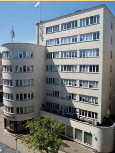
1. Budynek biurowy ZUS, obecnie Urząd Miasta Gdyni – pierwszy wpisany do rejestru zabytek modernistyczny Gdyni
