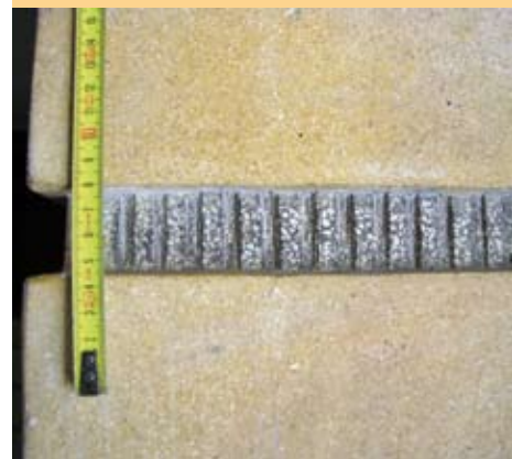
16. Wykończenie elewacji z tynków szlachetnych na elewacji budynku przy ul. 3 Maja 27-31 po odrestaurowaniu
