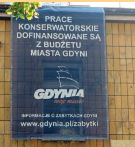
13. Nośnik informacyjny o dofinansowaniu prac z budżetu Gminy Gdynia, zawieszony na zabytku poddawanych konserwacji 13. Information carrier about the co-financing of the works from the budget of the Gdynia Commune, hung on the monument undergoing conservation
