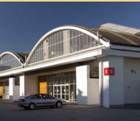
19. Hale garażowe z 1939 r. zaadaptowane na Pomorski Park Naukowo-Technologiczny 19. Halls from 1939 adapted for the Pomeranian Science and Technology Park
