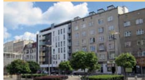
12. Współczesna kamienica przy Placu Kaszubskim, wpisana w historyczną zabudowę zgodnie z zapisami miejscowego planu zagospodarowania przestrzennego 12. A contemporary apartment house at Kaszubski Square, inscribed in the historic buildings in accordance with the provisions of the local spatial development plan
