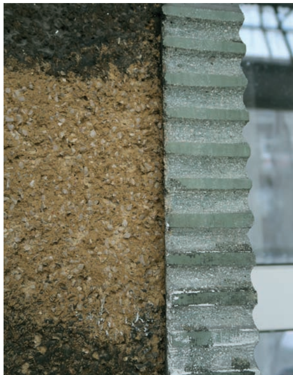
16. Fragment dekoracji z zielonego tynku na tle żółtego tynku na kamienicy przy ul. Świętojańskiej 46 w trakcie oczyszczania
