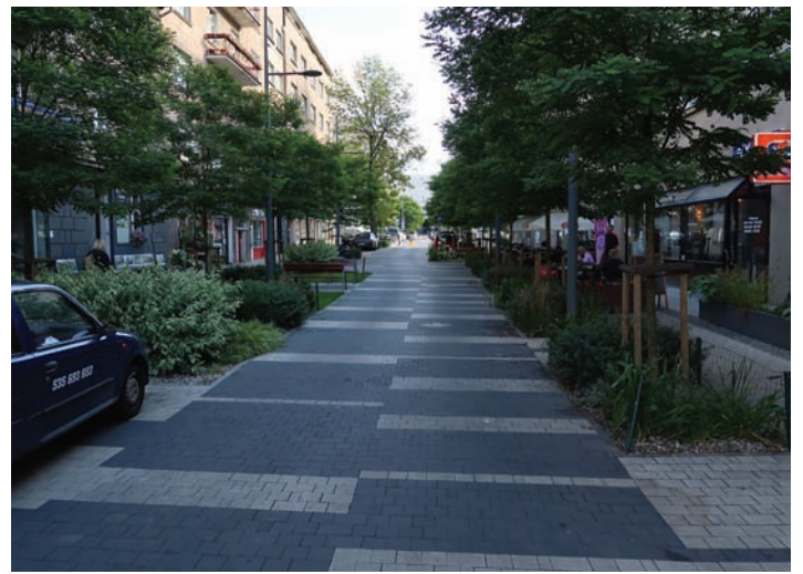
7. Odcinek ulicy Abrahama przebudowany na tzw. woonerf
