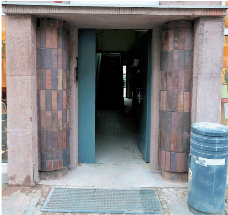
12. Portal kamienicy przy ul. Świętojańskiej 82 po odrestaurowaniu
