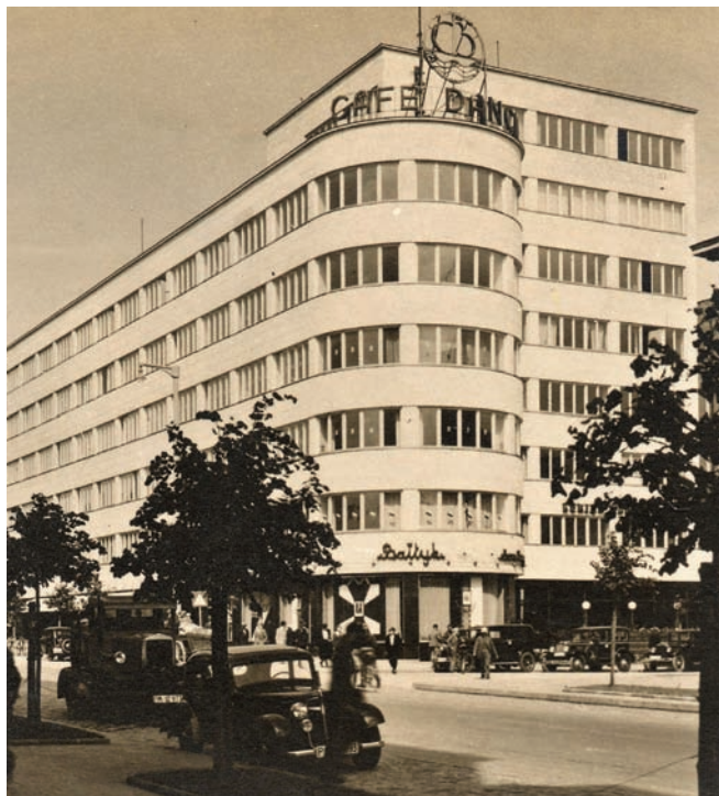
10. Siedziba ZUS przy ul. 10 Lutego 24 – jeden z najbardziej rozpoznawalnych budynków międzywojennej Gdyni, na fotografii z lat 30. XX w. sprawia wrażenie białego. W rzeczywistości elewacje są obłożone płytami wapiennymi o żółto-szarym kolorze
