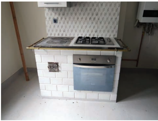
24. Kuchnia węglowa w willi z lat 30. XX w. przystosowana do współczesnych potrzeb
