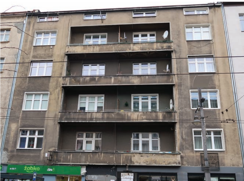
15. Kamienica przy ul. Świętojańskiej 46 przed pracami restauratorskimi
