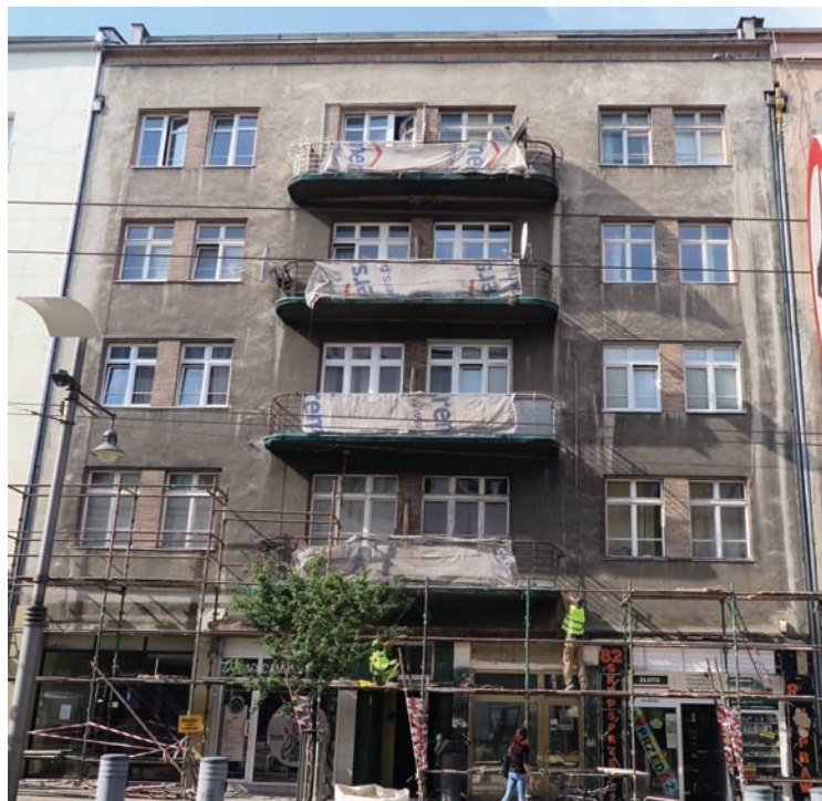
11. Kamienica przy ul. Świętojańskiej 82 przed pracami restauratorskimi
