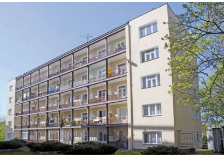
8. Elewacja południowa budynku przy ul. Partyzantów 39 nr II, stan obecny, fot. Bartłomiej Ponikiewski, rok 2019)
