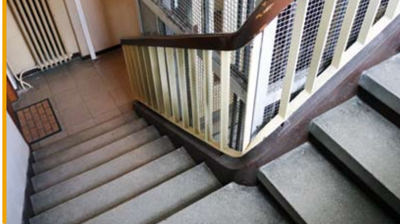
20. Fragment klatki schodowej budynku nr III z oryginalnym wykończeniem schodów i szybem windy, stan obecny (fot. Jakub Andrzejewski, 2019)
