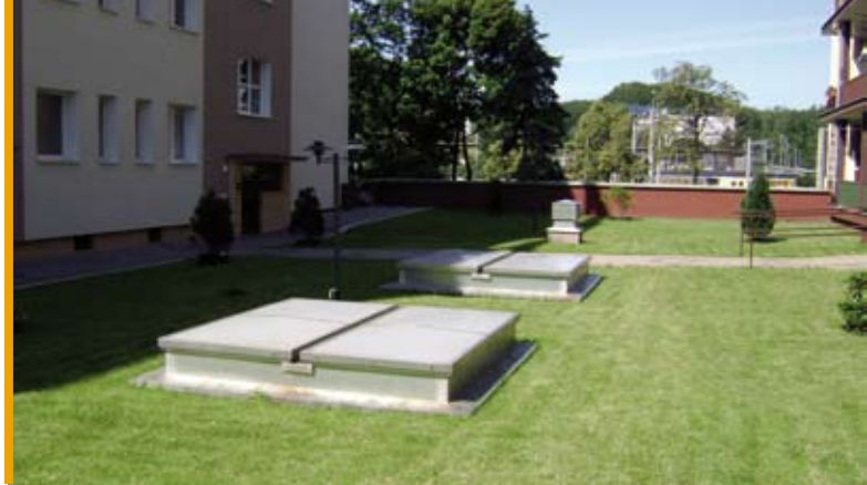
18. Podwórze pomiędzy budynkami nr II i III z widocznymi studzienkami świetlików, stan obecny (fot. Biuro MKZ Gdynia, 2012)
