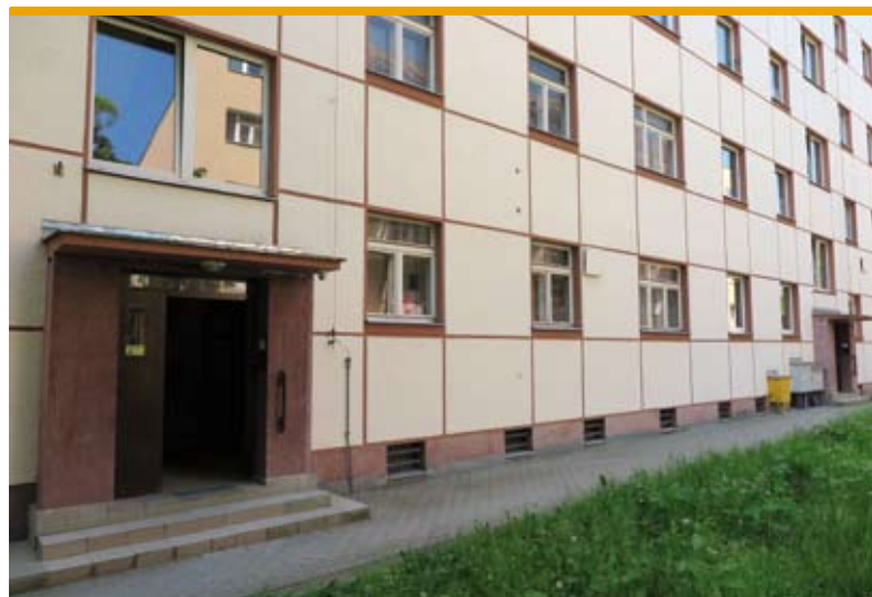
9. Szczegóły wykończenia elewacji północnej budynku nr IV, stan obecny (fot. Biuro MKZ Gdynia, 2019)
