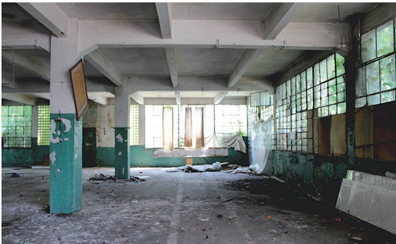
6. Krapkowice (Polska), budynek fabryczny, ul. Jana Kilińskiego 1, początek budowy 1931 r. (fot. autorka, 2019) 6. Krapkowice (Poland), manufacture building, 1 Jana Kilińskiego St, beginning of the construction 1931 (photo. author, 2019)
