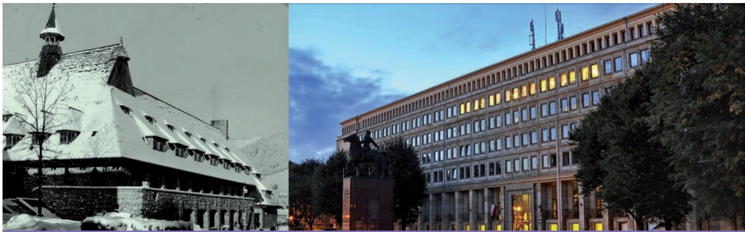
2. Architektura polska około 1950 roku. Po lewej - Dom Turysty, Zakopane 1951, architekci: Zbigniew Kupiec i Tadeusz Brzoza. Po prawej - biurowiec CRZZ, Katowice 1950, architekci: Henryk Buszko i Aleksander Franta
