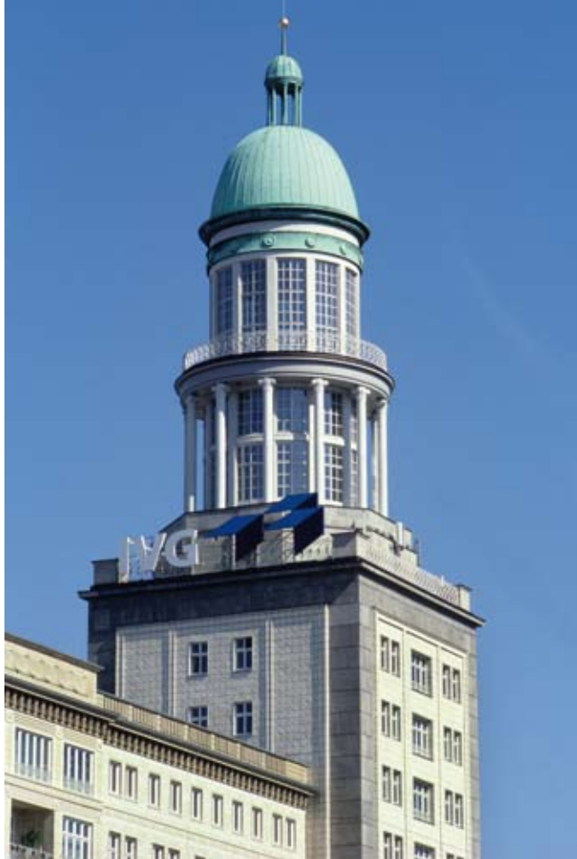
5. Karl-Marx-Allee, pierwszy etap budowy – zwieńczona kopułą wieża przy placu Frankfurter Tor przywołuje motyw wież dwóch klasycystyczno-barokowych katedr francuskiej i niemieckiej na Gendarmenmarkt (źródło: Landesdenkmalamt Berlin / Wolfgang Bittner)
