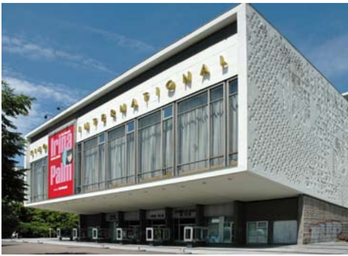
10. Kino International projektu Josefa Kaisera i Güntera Kurnerta, budowa: 1961-63 r. u zbiegu Schillingstraße i Karl-Marx-Allee (dawniej Stalin-Allee), drugi etap budowy (źródło: Landesdenkmalamt Berlin / Wolfgang Bittner)
