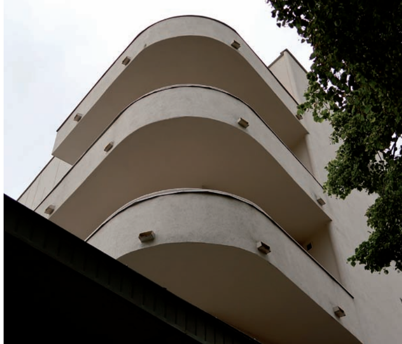
10. Balkony od strony wschodniej budynku przy ul. Pułaskiego 5/ Żeromskiego 41-43, 2019 r., fot. R.Hirsch
