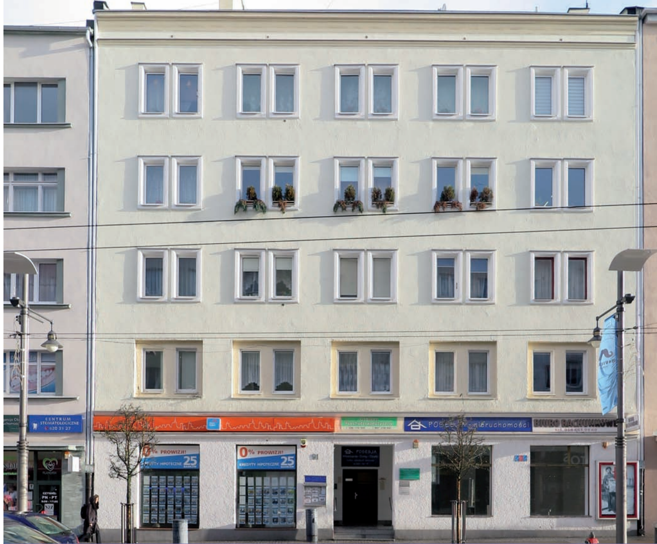
2. Elewacja frontowa kamienicy przy ul. Świętojańskiej 91 z przełomu lat 50. i 60. XX w., 2018 r. fot. R.Hirsch 2. Elevation of the townhouse in ul. Świętojańskiej 91 from between the 1950s and 1960s, 2018, photo R.Hirsch
