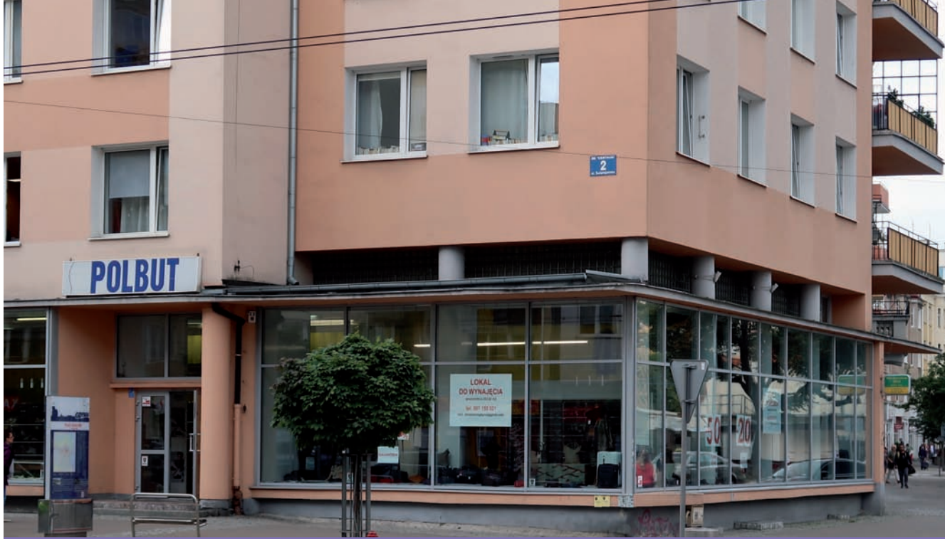
9. Wyeksponowana konstrukcja w budynku przy skrzyżowaniu ulic Starowiejskiej i Świętojańskiej 2, 2019 r., fot. R.Hirsch 9. The exposed structure of the building at the intersection of Starowiejska and Świętojańska 2, 2019, photo R. Hirsch
