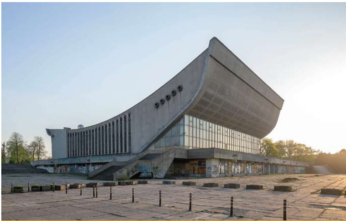
2. Wileński Pałac Sportu zbudowany w 1971 r., stan w 2019 roku (fot. N. Tukaj, 2019)
