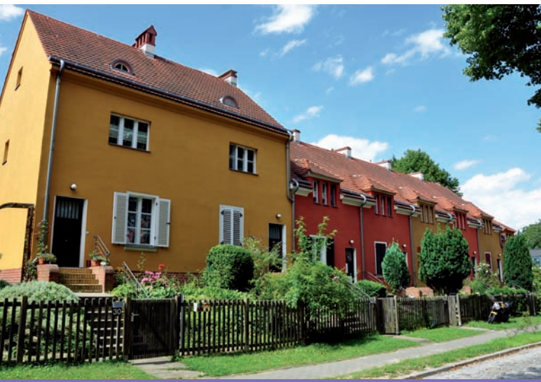
1. Berlin - Treptow, osiedle Falkenberg, Gartenstadtweg 16-30, proj. Bruno Taut, 1913 - 1916, proj. odtworzenia kolorystyki Winfried Brenne (fot. R. Czajka, 2016)
