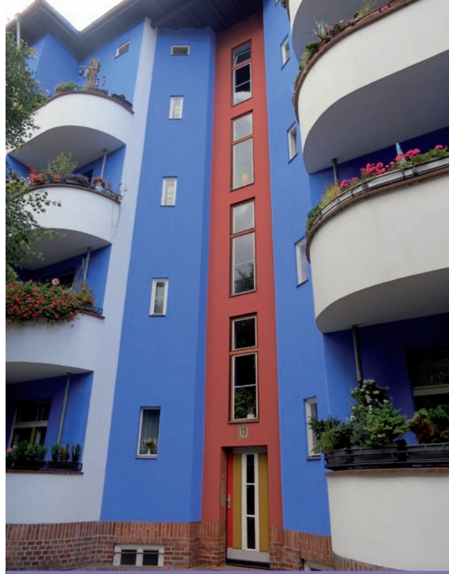
8. Berlin - Prenzlauer Berg, Heinz Bartsch Strasse 13, proj. Bruno Taut, 1926-1927, proj. odtworzenia kolorystyki Winfried Brenne (fot. J. Urbanik, 2015)
