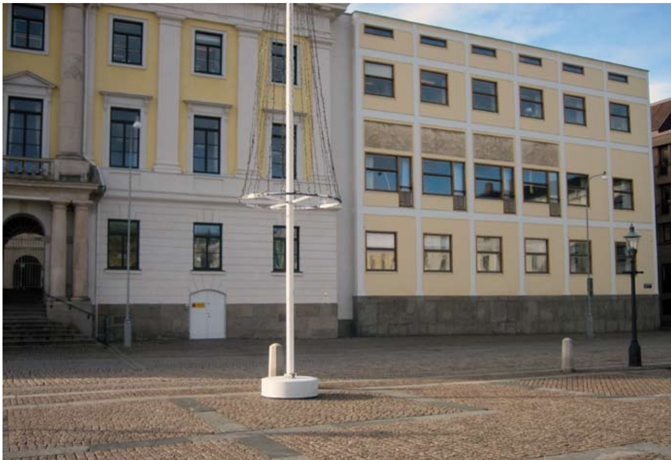
2. Gunnar Asplund, Rozbudowa gmachu sądu w Goeteborgu zrealizowana w latach 1934-37.
