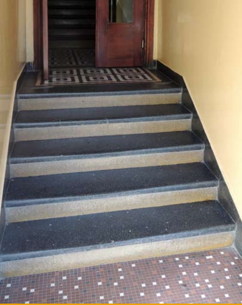
13. Sień budynku przy ul. Słupeckiej 9, 2018 r. (fot. W. Szerle)
