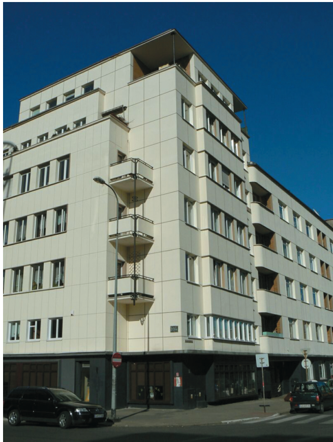
Fot. Narożnik przy skrzyżowaniu ul. 3 Maja i ul. Batorego po renowacji, 2006 r.
