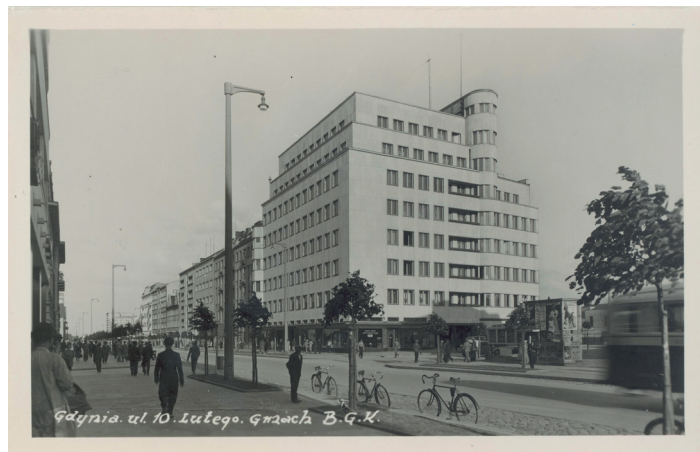
Fot. Pierwsza część budynku po zakończeniu, 1936 r.
