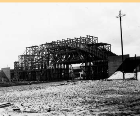
8. Budowa wiaduktu w drodze do portu nad torami do... portu 8. Construction of a viaduct on the way to the port
