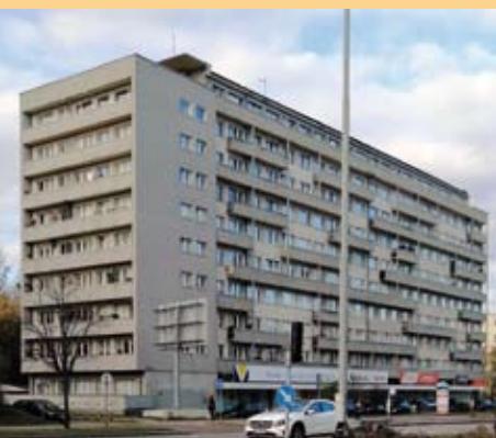
20. Budynek mieszkalno-usługowy, ul. Władysława IV, arch. J. Chmiel 20. Residential and service building, Władysława IV Street, arch. J. Chmiel
