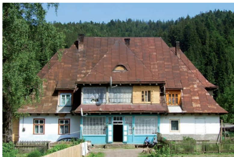
11. Tatarów, pensjonat Schafferów, widok od zachodu, proj. arch. Maxa Zuckera, 1938 r. (fot. J. Czubiński, 2007 r.)
