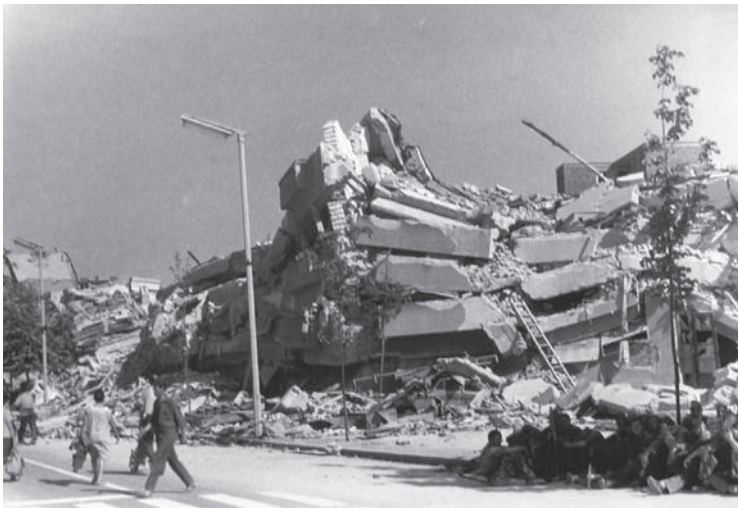
3. Zniszczenia spowodowane trzęsieniem ziemi w Skopje w 1963 r. (źródło: Skopje1963_plostad-sloboda@public domain)
