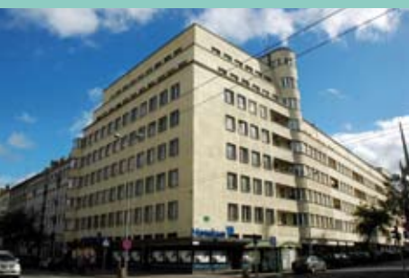
14. Budynek mieszkalny FE BGK, ul. 3 Maja 27/31
