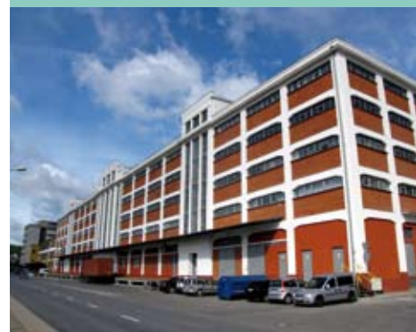
36. Magazyn Długoterminowy „H”, ul. Polska 17 – po przeprowadzeniu prac restauratorskich
