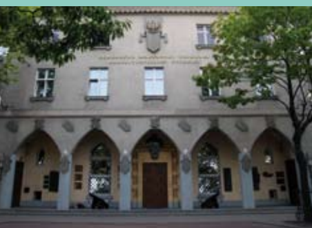
2. Budynek Żeglugi Polskiej, ul. Waszyngtona 44
