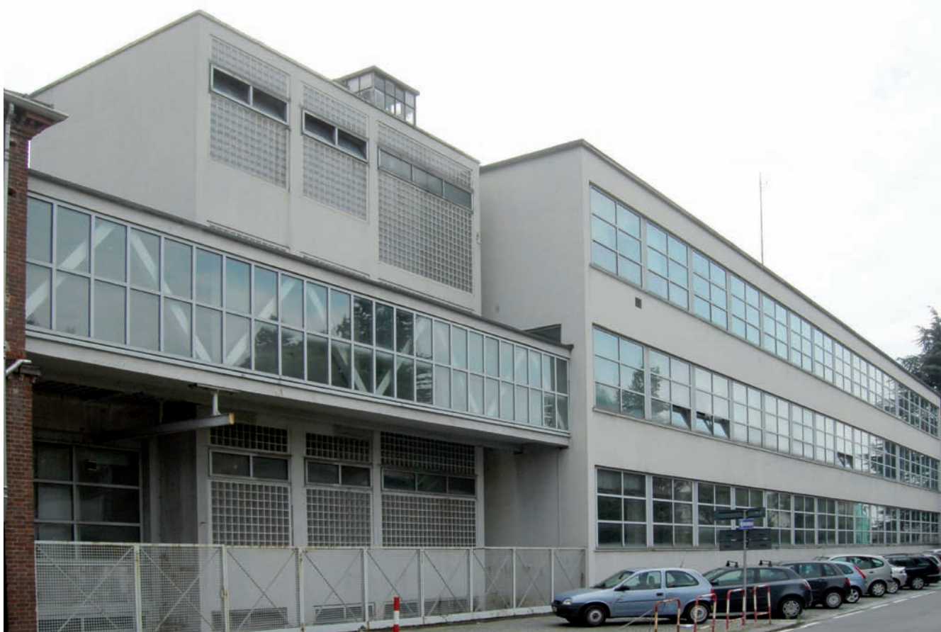
5. Ivrea, pierwszy etap rozbudowy fabryki Olivettich, architekci Luigi Figini i Gino Pollini, 1934 (fot. autor) 5. Ivrea, 1st enlargement of Olivetti factory, architects Luigi Figini and Gino Pollini, 1934
