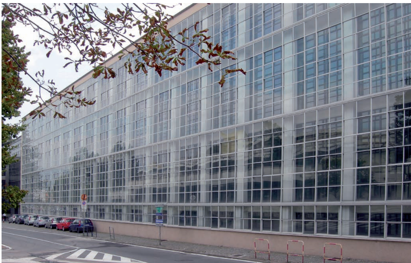
6. Ivrea, „Centralne ICO” – trzeci etap rozbudowy fabryki Olivettich, architekci Luigi Figini i Gino Pollini, 1942 (fot. autor) 6. Ivrea, „Central ICO” – 3rd enlargement of Olivetti factory, architects Luigi Figini and Gino Pollini, 1942 (photo by author)
