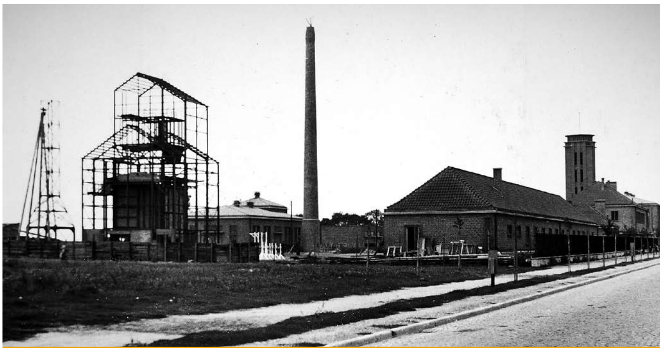
2. Toruń, nowa gazownia miejska przy ul. Lubickiej 52-58 w trakcie budowy, 1940 r. (źródło: Archiwum Państwowe w Toruniu, Zbiór fotokopii i fotografii, Kurt Grimm, sygn. 539)
