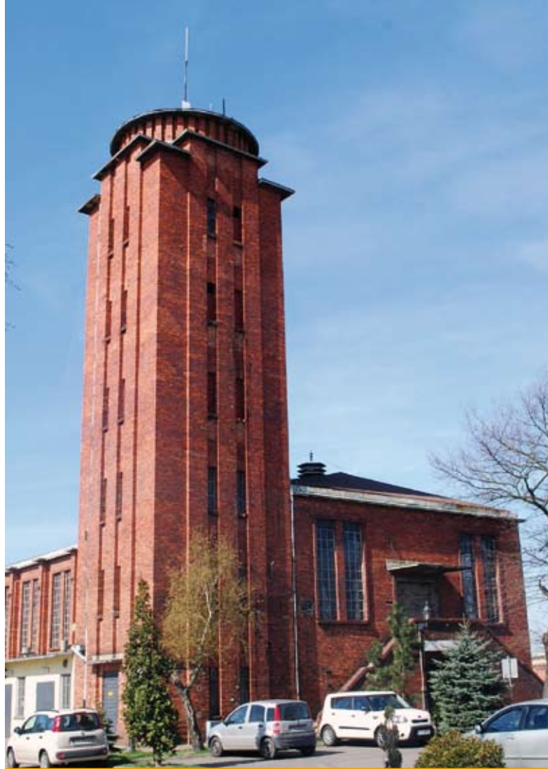
7. Toruń, nowa gazownia miejska, aparatuwnia wraz z wieżą, widok od strony wschodniej, ul. Lubicka 52-58, 1938-1942, (fot. Jakub Polak, 2017)
