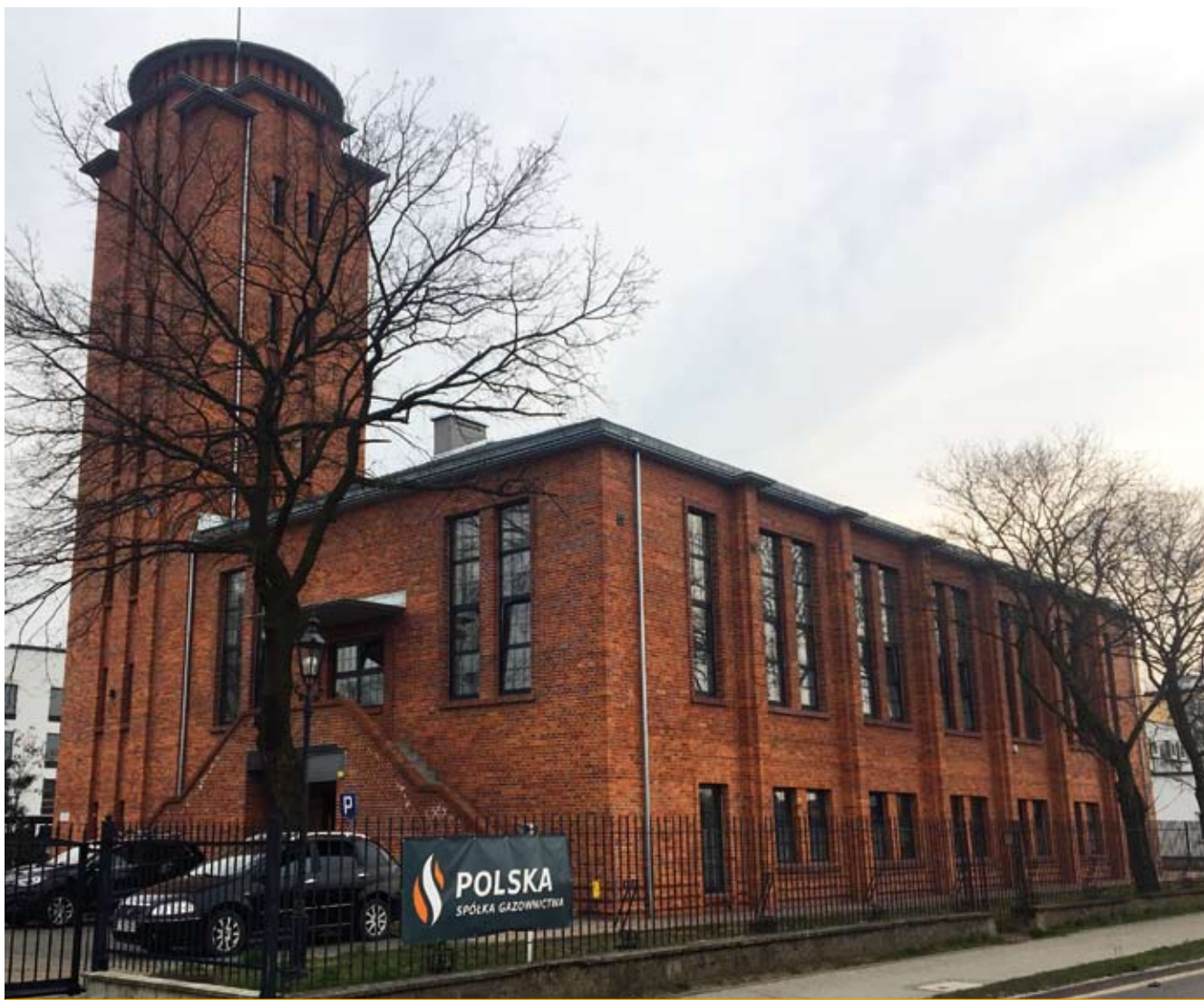
4. Toruń, główny budynek nowej gazowni miejskiej – aparatownia z wieżą po pracach renowacyjnych w 2018 r., ul. Lubicka 52-58, 1938-1942 (fot. Jakub Polak, 2020)
