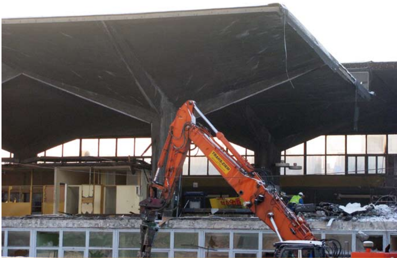
7. Burzenie dworca w Katowicach, 2010/2011, fot. B. Błachuta (źródło: zbiory Miejskiego Konserwatora Zabytków w Katowicach)
