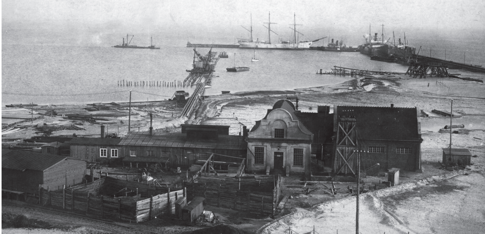
1. Gdynia-Port, obecnie ul. Warsztatowa 6, budynek pierwszej elektrowni portowej, lata 20. XX w., ze zbiorów Muzeum Miasta Gdyni
