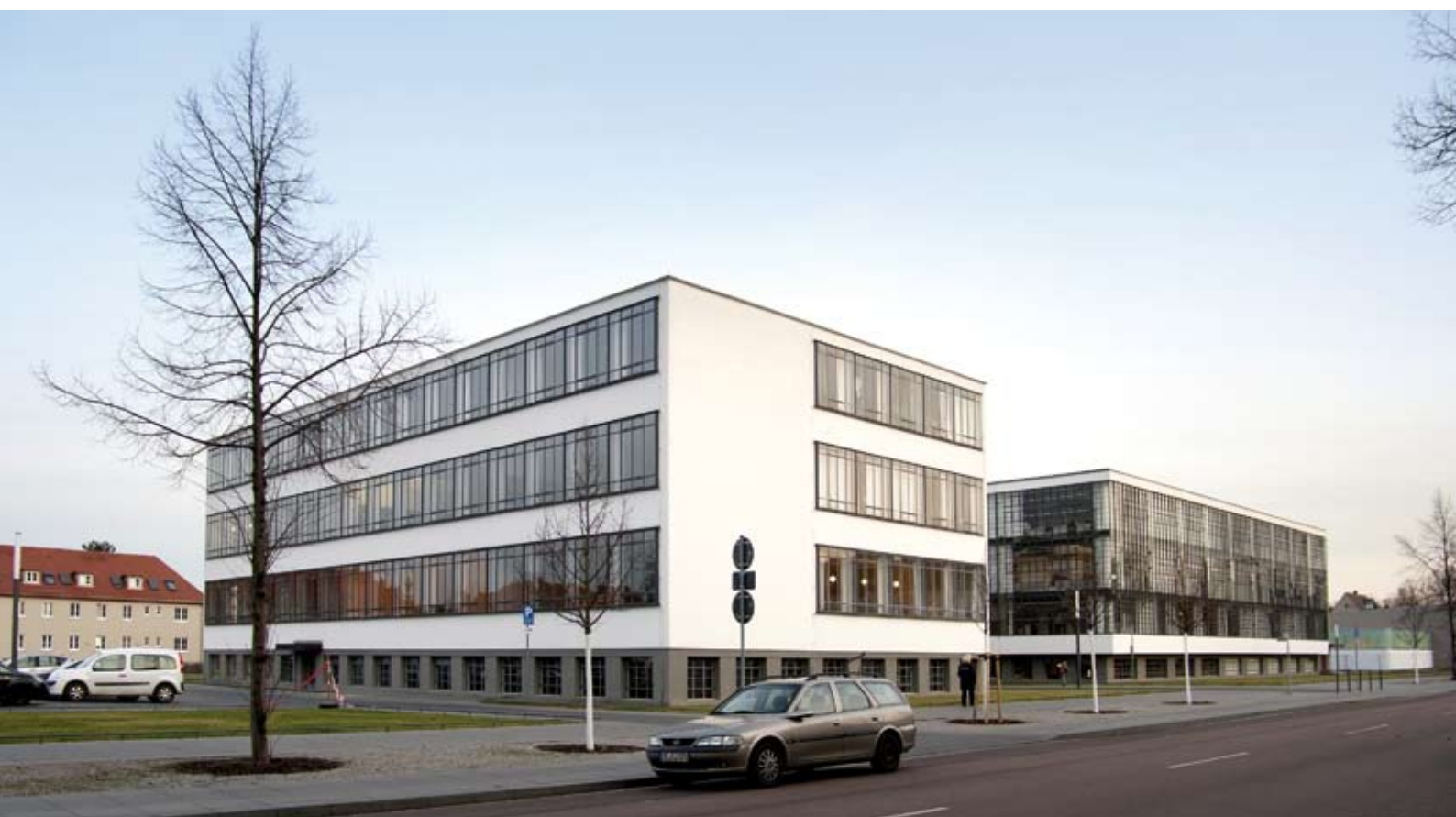
9. Północna elewacja północnego skrzydła po zamontowaniu nowych okien (oprac. Yvonne Tenschert, 2012, Bauhaus Dessau Foundation)
