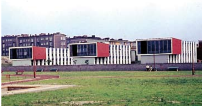
10. Szkoła przy ul. M. Grażyńskiego w Katowicach-Koszutce, projekt Stanisław Kwaśniewicz, 1958-59, realizacja 1960-62 (fotografia ze zbiorów Juranda Jareckiego)
