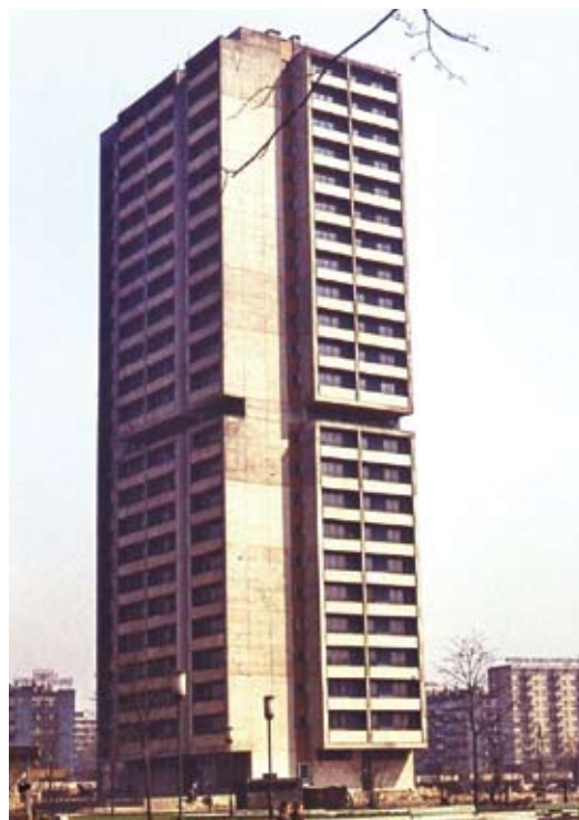
8. Budynek mieszkalno-usługowy „24-K” przy ul. Sokolskiej, projekt Jurand Jarecki i Marian Skałkowski, 1965-66 (fot. ze zbiorów Juranda Jareckiego)
