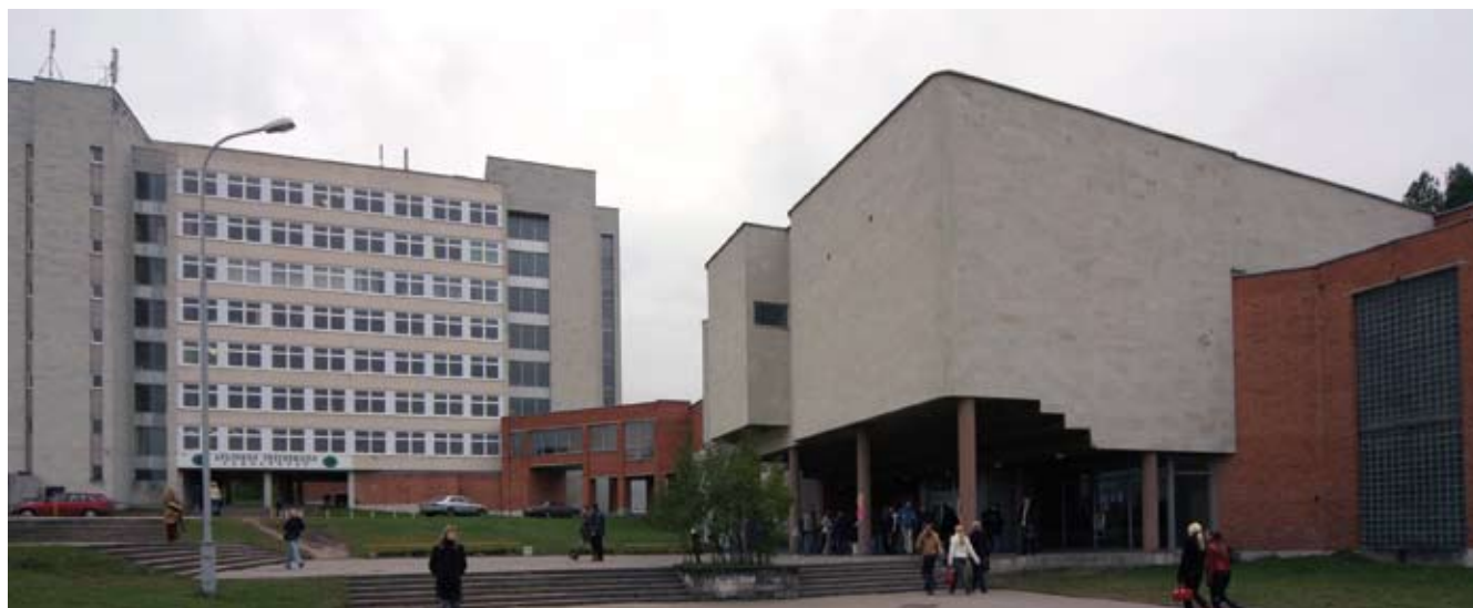
9. Fragment kompleksu Politechniki Wileńskiej (VGTU), zrealizowanego w latach 1970–85, architekt Julius Jurgelionis (fot. z archiwum Archfondas, 2004 r.)
