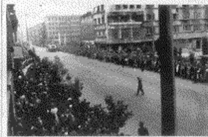
ul. Świętojańska. Rok 1945 spalony dom Skoczerów po wyzwoleniu przez Armię Czerwoną
