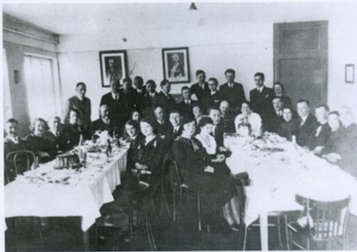
Pracownicy firmy „P A N T A R E I” Powszechne Zakłady Magazynowe i Transportowe SA w Gdyni
