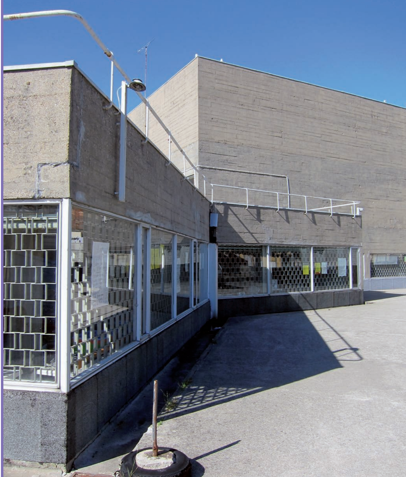
1. Álvaro Siza, Spółdzielnia Lordelo de Ouro (Porto 1960-63); skrót perspektywiczny elewacji południowej budynku w obecnym wyglądzie i stanie zachowania (fot. V. Riso)
