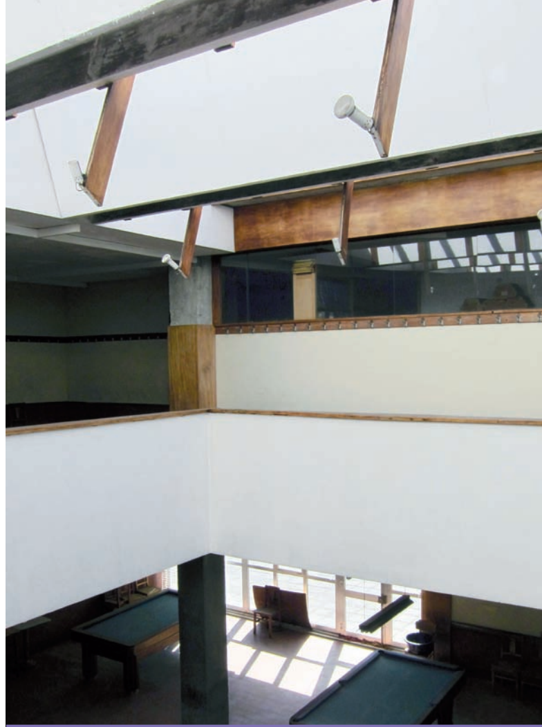
2. Álvaro Siza, Spółdzielnia Lordelo de Ouro (Porto 1960-63); (pierwotnie 3-piętrowe) wysokie atrium oświetlane przez okna dachowe w wyższym bloku kubaturowym po odcięciu na poziomie pierwszego piętra (fot. V. Riso)
