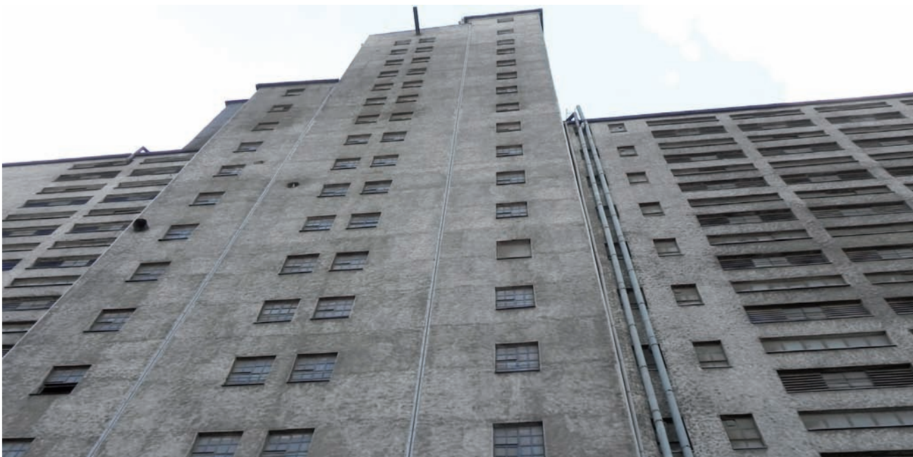
9. Fragment elewacji wschodniej części środkowej – 2014 r. (fot. Aleksandra Hamberg-Federowicz)
