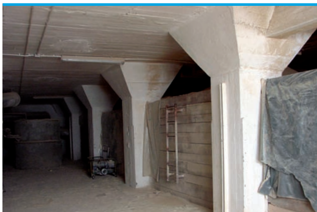
4. Elewator „Ewa”, Szczecin - wewnątrz magazynów w poziomie piwnicy – 2009 r., (fot. Aleksandra Hamberg-Federowicz)
