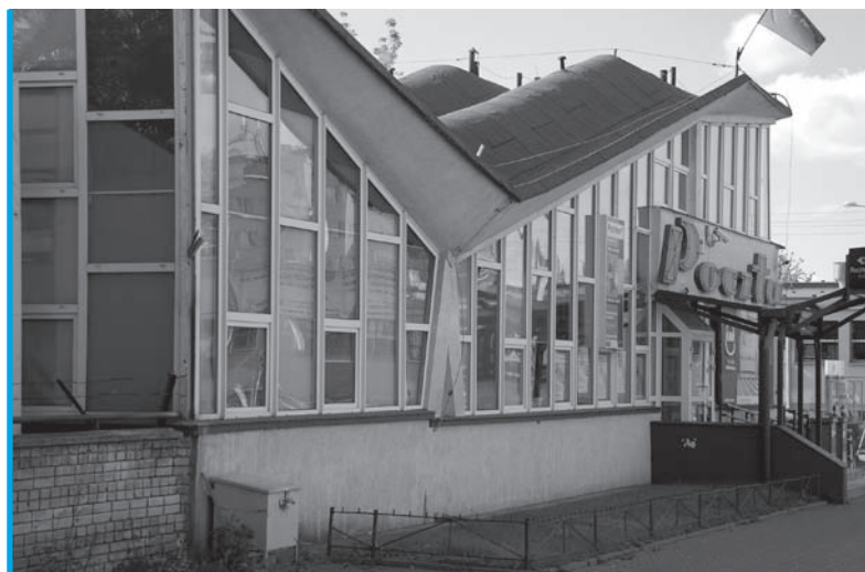
6. Budynek poczty kolejowej, Białystok, ul. Kolejowa 15, 1965, L. Kulikowski (fot. M. Czarnecki, 2012)
