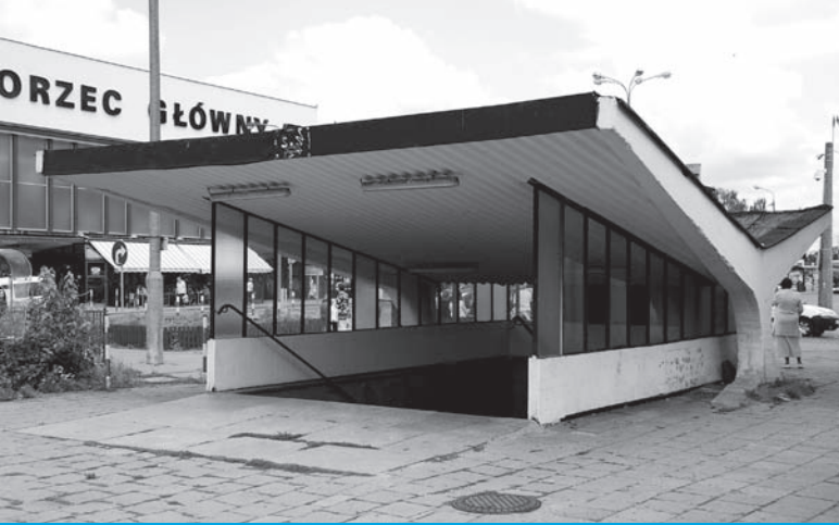
5. Zejście do tunelu pod Dworcem Głównym, Bydgoszcz, ok. 1968 (fot. M. Czarnecki, 2011)
