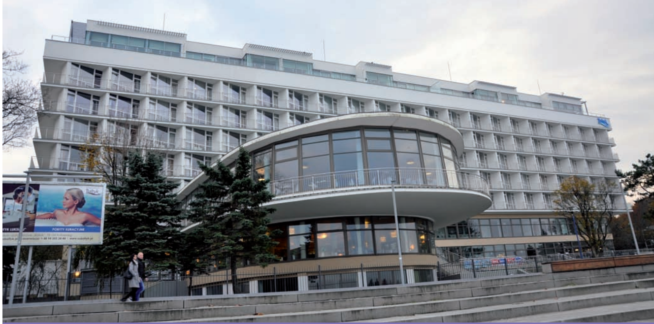
3. Kołobrzeg, sanatorium Centralnej Rady Związków Zawodowych, architekci E. Goldzamt, H. Gurjanowa, 1964 (fot. B. Ciarkowski) 3. Kołobrzeg, CRZZ spa, E. Goldzamt, H. Gurjanowa, 1964 (photo B. Ciarkowski)
