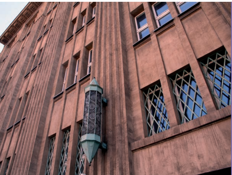
2. Siedziba Polskiej Akcyjnej Spółki Telefonicznej w Łodzi przy al. Kościuszki 12, wybudowana w latach 1926-29 według projektu Józefa Kabana (fot. autorka)
