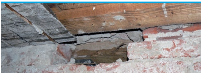
3. Budynek na terenie Działek Leśnych w Gdyni - sposób wykonstruowania ściany działowej z cegły ceramicznej pełnej bez zastosowania żebra poszerzonego w poziomie stropu międzykondygnacyjnego (fot. Maciej Niedostatkiwicz)
