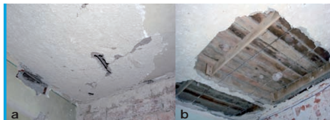
4. Budynek na terenie Działek Leśnych w Gdyni - rozwiązanie międzykondygnacyjnego stropu skrzynkowego (zamkniętego): a. zarysowana płyta dolna stropu pełniąca rolę podsufitki, b. zbrojenie podsufitki prętami w zwiększonym rozstawie (fot. Maciej Niedostatkiwicz)
