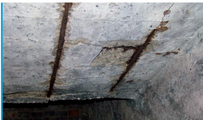
5. Budynek na terenie Działek Leśnych w Gdyni - zbrojenie płyty biegowej klatki schodowej – widoczny brak otuliny oraz zwiększony rozstaw prętów zbrojenia głównego, brak prętów rozdzielczych (fot. Maciej Niedostatkiewicz)
