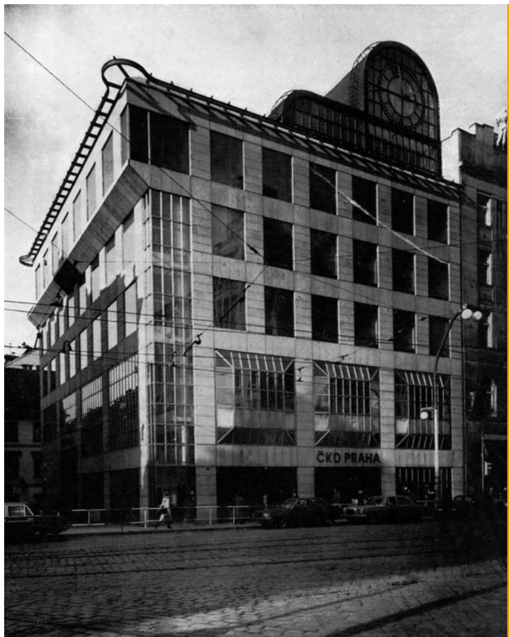
2. Praga, budynek administracyjny ČKD, ul. Na Příkopě 388, proj. Alena Šrámková i Jan Šrámek, 1974–1983 („Architektura ČSR”, 1985, t. 7, s. 294)
