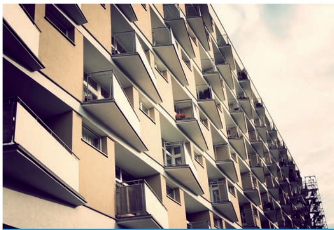
7. Budynek mieszkalny przy Placu Waryńskiego w Poznaniu po remoncie (Ultra Architects), źródło: http://modernistyczny-poznan.blogspot.com (fot. Marcin Stachowiak)
