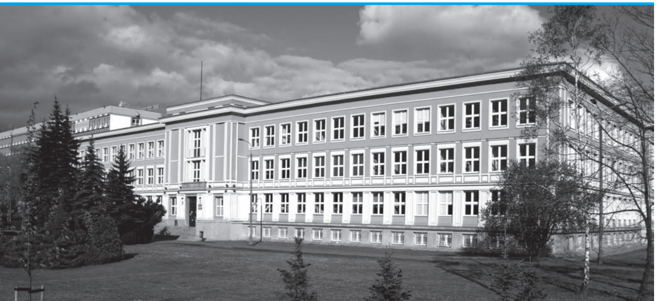
6. Modernizacja budynku Wydziału Budownictwa i Inżynierii Środowiska Politechniki Poznańskiej przy ul. Piotrowo (fot. Piotr Chojnacki)
